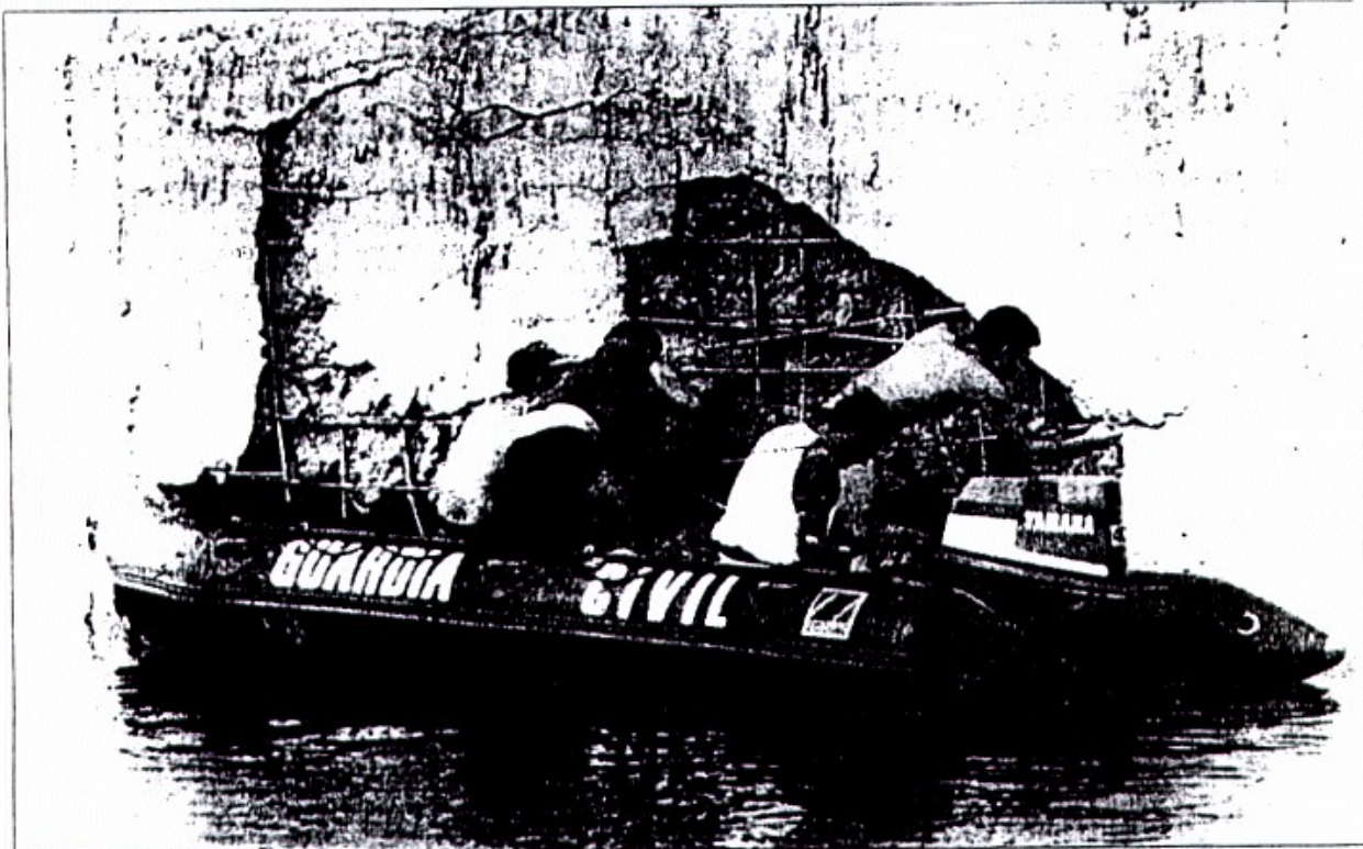
Efectius de la Guàrdia Civil inspeccionen el primer forat que va aparèixer al viaducte del pantà de la Baells. foto: EFE.
